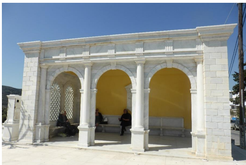
Σταθμός λεωφορείου στον Πύργο
