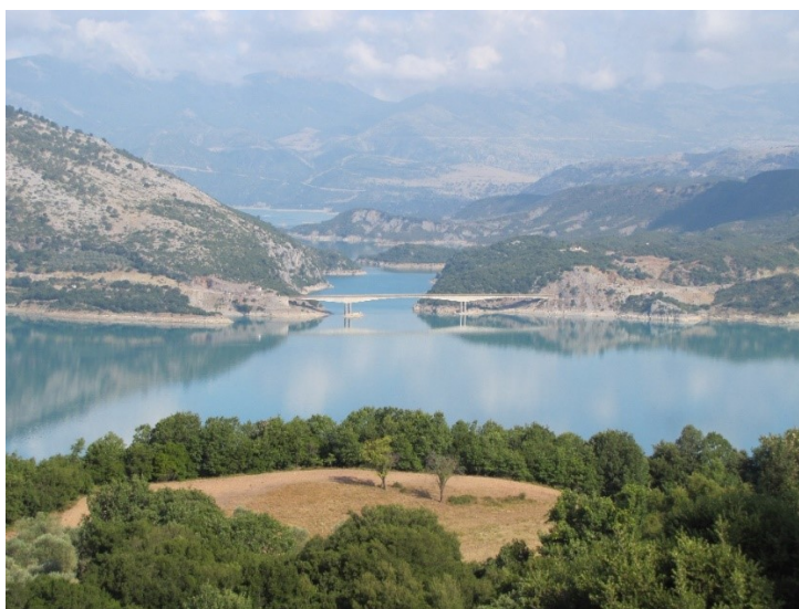
Λίμνη Κρεμαστών με την Γέφυρα Τατάρνας στο βάθος.
