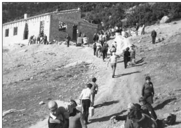
1979. Ο Ορεινός στο στάδιο της κατασκευής.
