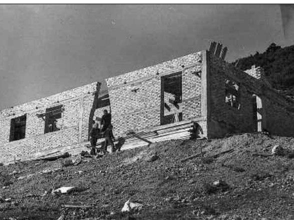
Κατασκευή του Ξενώνα 1978 ▲
