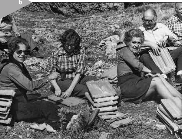
Κεφαλάρι 11-11-78, Κουβαλώντας υλικά για το κτίσιμο του Ξενώνα ▲
