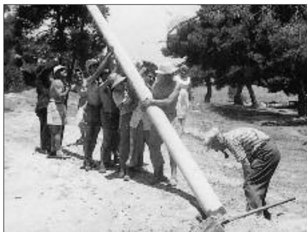
1956, Κατασκήνωση. Υψώνεται η πρώτη κολώνα για το ρεύμα. Φωτ. Ε. Καφετζοπούλου ▲
