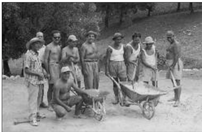
Ιούνιος 1959. Εργασίες στην Κατασκήνωση. Φωτ. Ε. Καφετζοπούλου ▲
