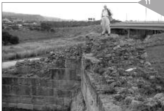
Φωτ. 1.: Διακρίνεται μέρος του εναπομείναντος Εξαμιλίου κοντά στο χωριό Κυράς Βρύση και στη γέφυρα της νέας εθνικής οδού.
