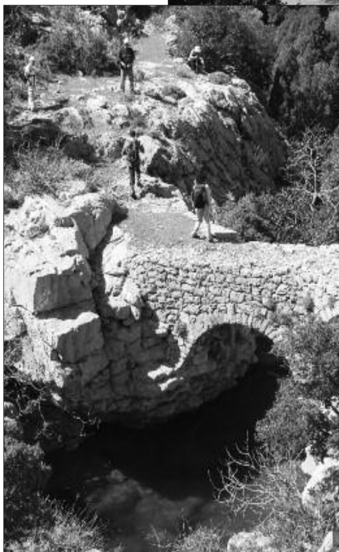
Γεφυράκι στο Φαράγγι της Κλεισούρας. ▲
